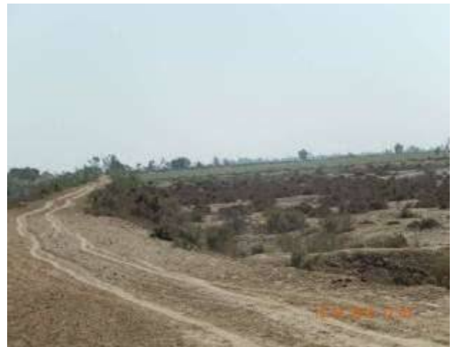
Borrow area-06 on IP of Mithrao canal RD- 51 N 25;58;35.29 E 69;1;28.68
